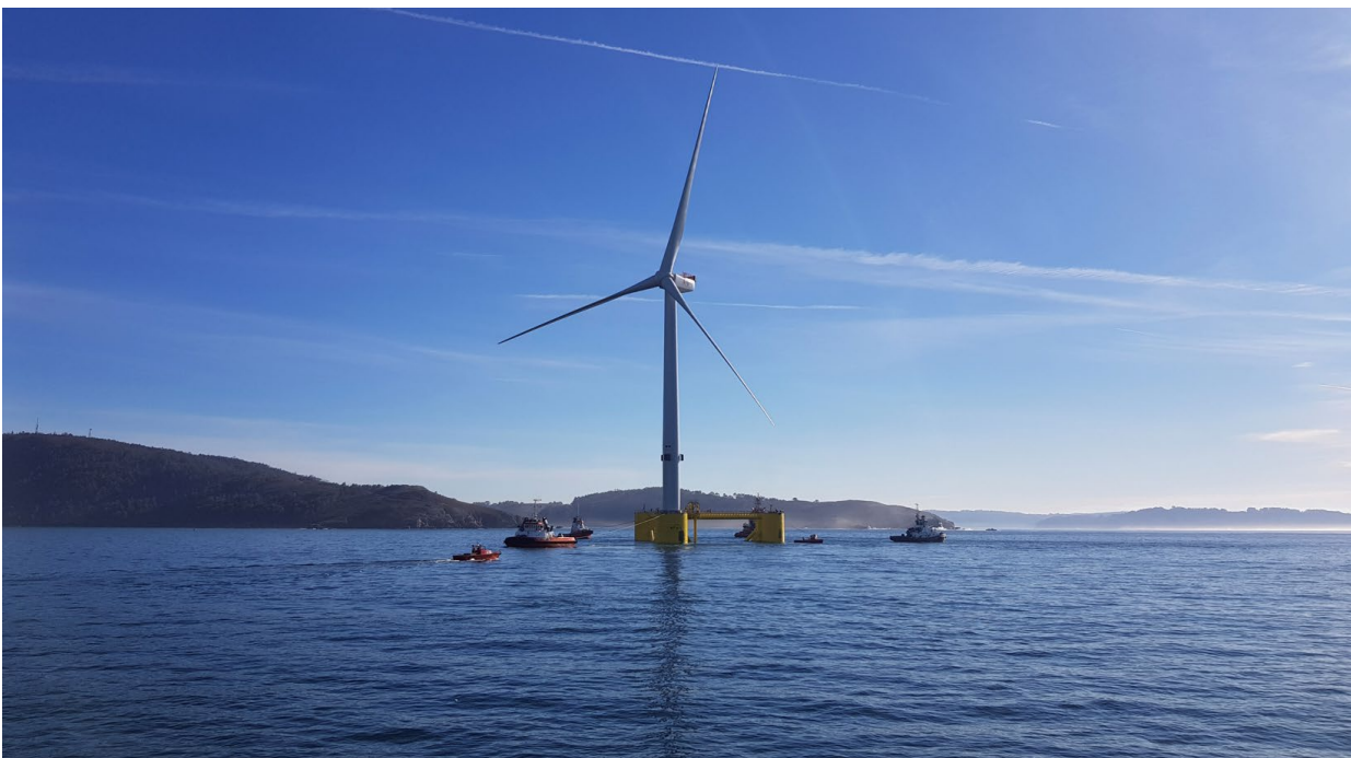
Joonis 5 Näide ujuvтуuliku pukseerimisest paigaldamiskohale
